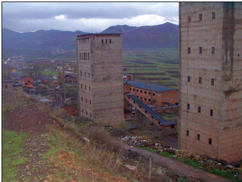
Εγκαταλειμμένα κτίρια ορυχείων στο Περένιας.
