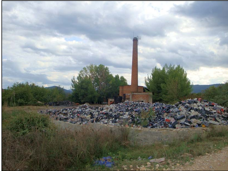
Περιοχή διάθεσης μπαταριών σε εγκαταλειμμένη βιομηχανική μονάδα παραγωγής ηλεκτρικών στοιχείων, στο Βεράτι.
