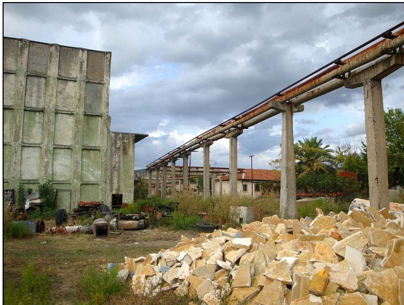
Εγκαταλειμμένη μονάδα υφαντουργίας στο Βεράτι.
